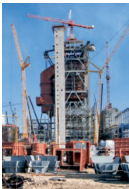
Blick durch die Webcam auf die Baustelle von Maritza in Bulgarien.
